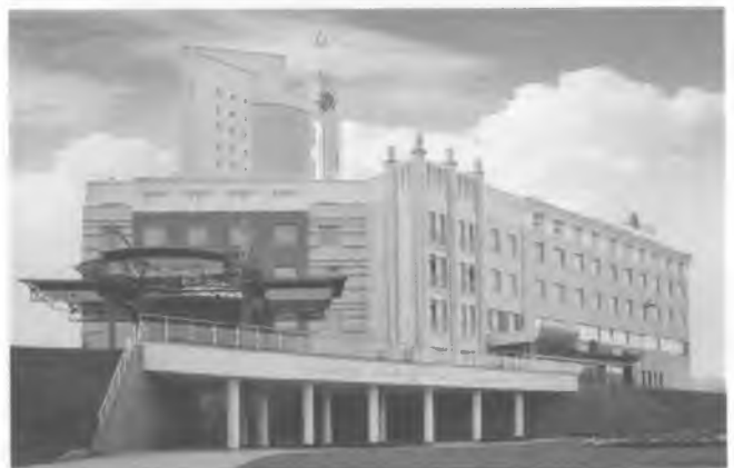
Гасцінічны комплекс «Вікторыя» ў жылым раёне Вяснянка.
