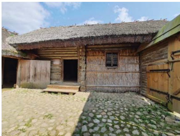
Панадворак хаты з в. Волева, Дубровенскі р-н Віцебскай вобл. БДМНАП. Фота Э. Крыштаповіч
